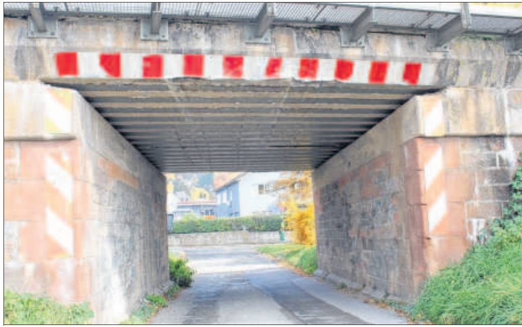
Für die mindestens fünfjährige Dauer der Sanierungsarbeiten an der Keßlergrube wird die Bahnunterführung Salzländeweg in Grenzach komplett gesperrt. Foto: Patrick Netzlaff
