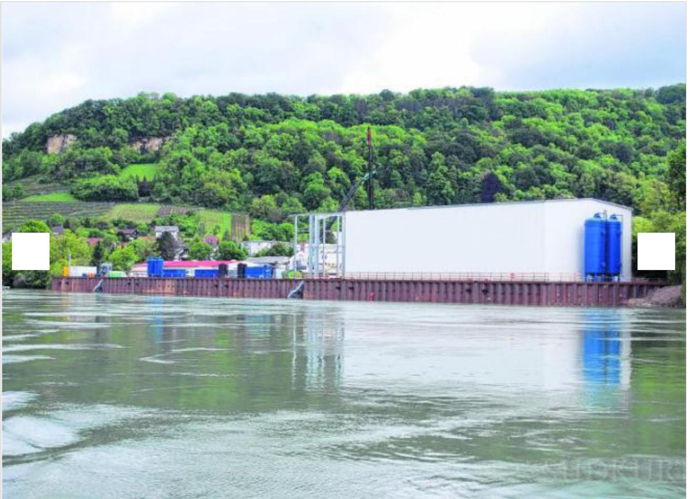
Grenzach-Wyhlen – Nach acht Monaten Bauzeit hat die Roche Pharma AG bei der Kesslergrube ihre temporäre Schiffsanlegestelle fertiggestellt. Sie soll es ermöglichen, das belastete Material, das aus der Grube ausgehoben wird, in Spezialcontainern per Schiff statt mit Lastwagen nach Weil zu transportieren, wo die Container auf die Bahn verladen werden.
