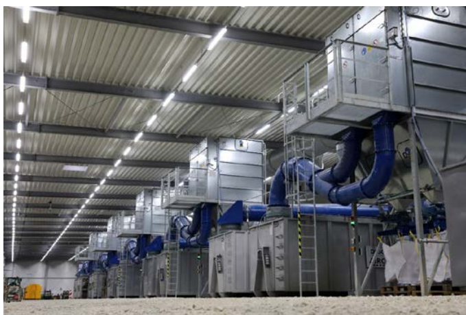
Die Montage der mehrstufigen Abluftreinigungsanlage im bereits sanierten Baufeld Nord konnte noch vor den Festtagen abgeschlossen werden; Quelle: Pressefoto Roche
