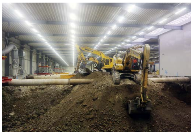
Am 14. Januar 2019 erfolgte der Startschuss für den Aushub im Baufeld Süd; Quelle: Pressefoto Roche
