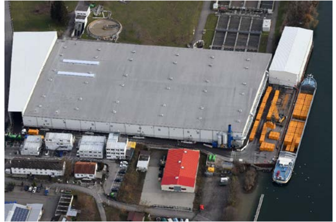
Ein befüllter Spezialcontainer wird auf den Schiffsanleger transportiert, wo er auf das bereitstehende Schiff verladen wird. Quelle: Pressefoto Roche
