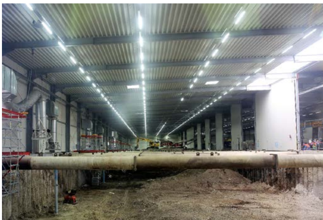
Die Sanierungsarbeiten auf dem Baufeld Süd schreiten planmäßig voran. Quelle: Pressefoto Roche
