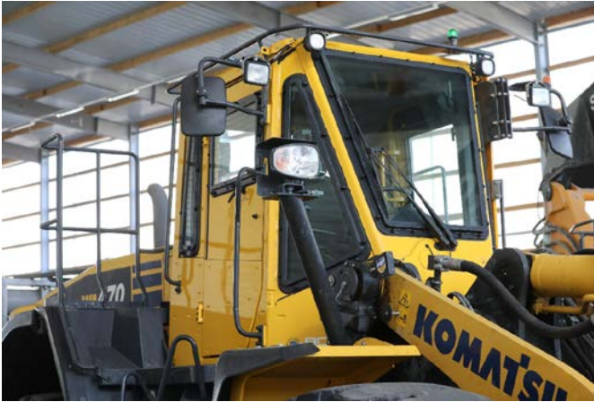
Neu unterstützt ein Radlader mit gepanzelter Kabine die Arbeiten auf dem Baufeld Süd. Quelle: Pressefoto Roche
