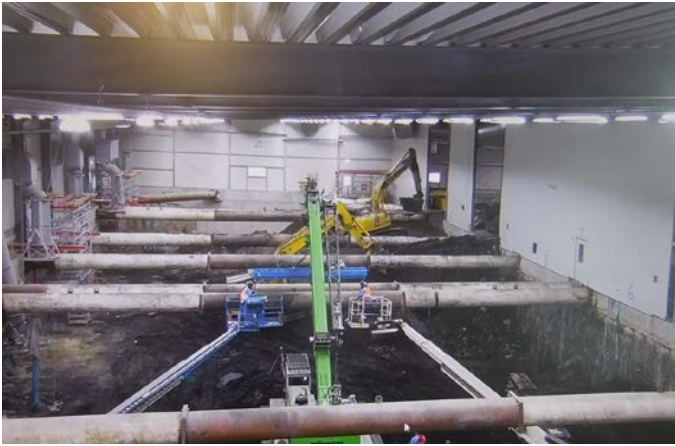
Mit einem Raupenteleskopkran werden einzelne Steifen angehoben und versetzt. Quelle: Pressefoto Roche
