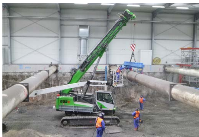
Der Aushub wurde Ende März unterbrochen und alle Steifen kontrolliert und nötigenfalls ersetzt. Quelle: Pressefoto Roche
