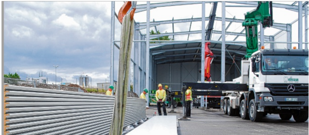
Für das Ausheben des belasteten Bodens werden luft- und schalldichte Hallen errichtet. BILDER: THOMAS LOISL MINK
