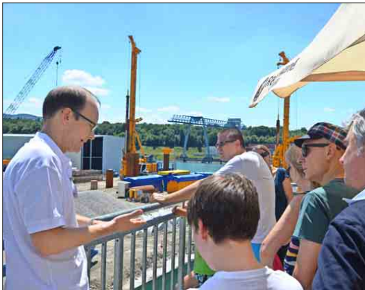
Ingenieur Thomas Osberghaus links bei einer Baustelleneinführung
