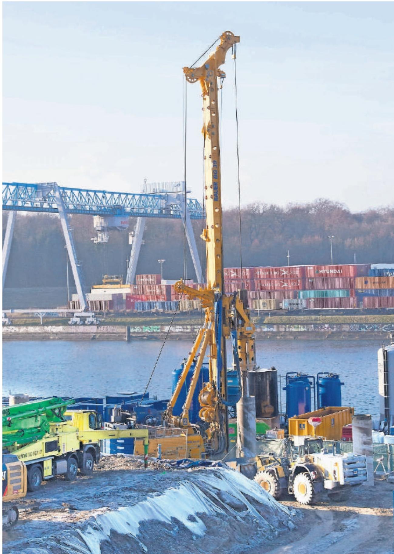
**Totalsanierung vor der Kulisse des Birsfelder Hafens: Die Roche Pharma AG hat bei den Grosslochbohrungen zur Vorbereitung des Aushubs des Chemie- und Hausmülls in der Kesslergrube die Halbzeit geschafft.**
