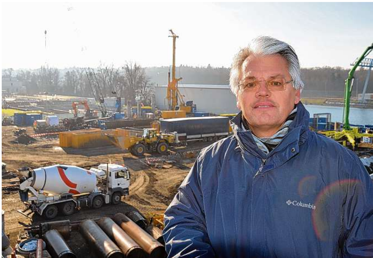
Der Gesamtprojektleiter und Altlastenbeauftragte der Roche weltweit, Richard Hürzeler, freut sich, dass bei den Großlochbohrungen auf der Kesslergrube jetzt die Halbzeit erreicht wurde. BILD: DOR
