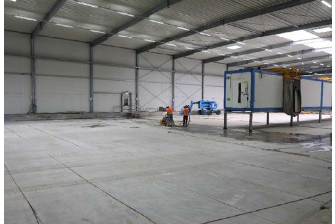
Die Stücke der Bodenplatte werden im Anschluss herausgelöst und einzelnen abtransportiert. Quelle: Pressefoto Roche.
