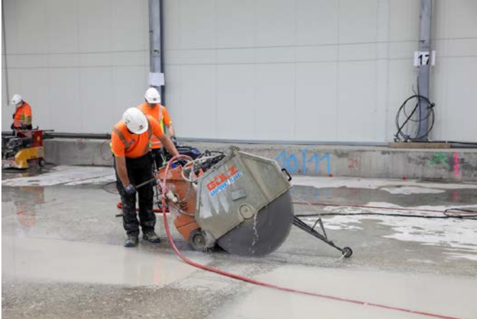
Derzeit findet der Abbruch der Betonplatte im Baufeld Mitte statt; dazu wird dies in Stücke zersägt. Quelle: Pressefoto Roche.
