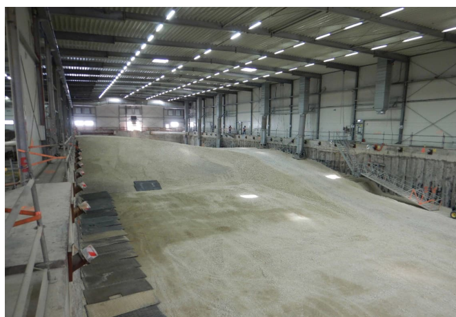
15 von insgesamt 25 Lagen sauberes Erdmaterial wurden eingebracht sowie eine neue Rampe erstellt.
