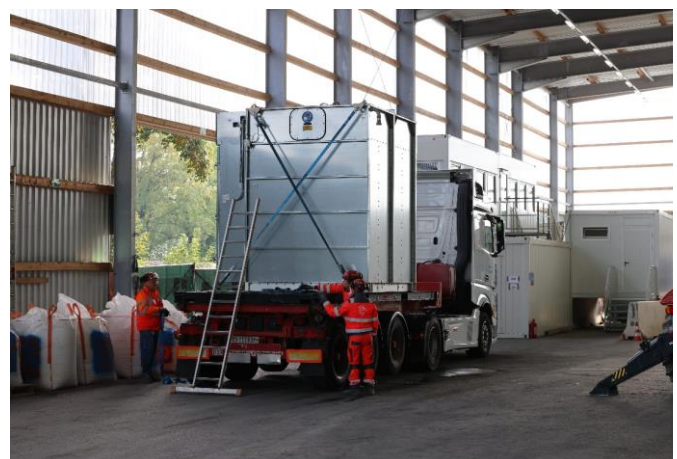
Ein Element des ersten Moduls der Abluftreinigungsanlage wird für den Abtransport vorbereitet. Quelle: Pressefoto Roche.
