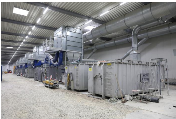
Ein Modul der Abluftreinigungsanlage wird demontiert. Quelle: Pressefoto Roche.
