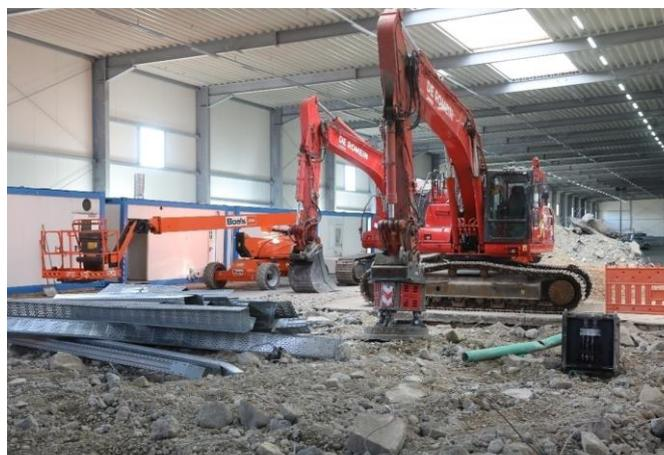
Für die Sanierungslogistik erstellte Asphalt- und Betonflächen werden entfernt und das Material der Wiederverwertung zugeführt.
