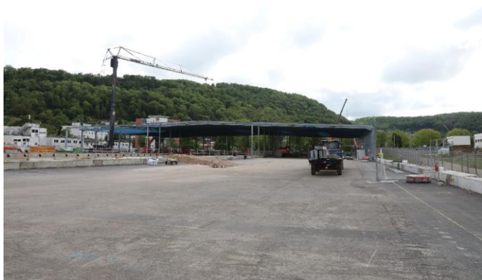
Ein Großteil der Sanierungseinhausung ist bereits zurückgebaut. Quelle: Pressefoto Roche.
