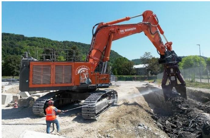
Aufgrund der eingesetzten Abbruchschere am Hitachi EX1200 kann der Beton möglichst lärmarm abgetrennt werden.
