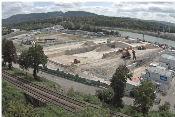
Die mächtige, 14 Tonnen schwere Abbruchschere verrichtet ihr Werk möglichst lärmschonend. Quelle: Pressefoto Roche.
