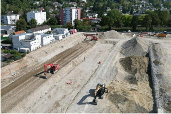
Im Teilbereich Mitte wird sauberes Erdmaterial für die qualifizierte Rückverfüllung zwischengelagert.
