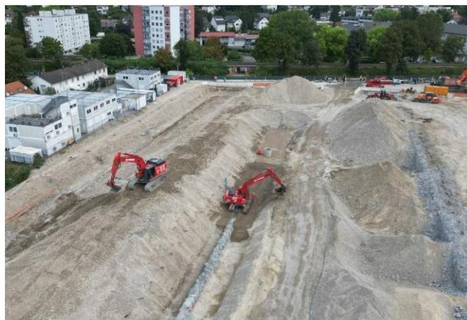
Weite Teile der Bohrpfahlwand sind bereits um die geplante Höhe eingekürzt. Quelle: Pressefoto Roche.
