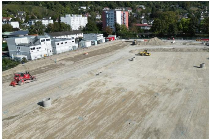
Lage um Lage wird frisches Erdmaterial eingebracht, verdichtet und überprüft. Quelle: Pressefoto Roche.
