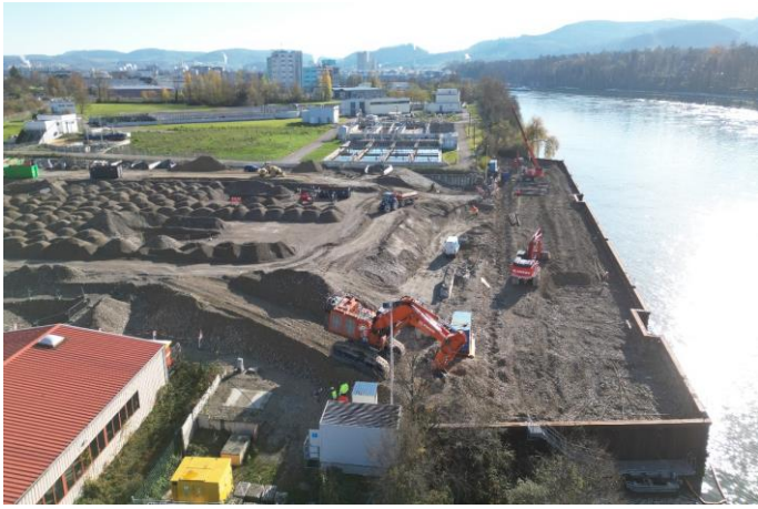
Der Rückbau des Schiffsanlegers schreitet voran. Die hintere Spundwand zur Landseite ist nahezu vollständig gezogen. Quelle: Pressefoto Roche.
