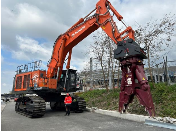
Die Baumaschine des Typs Hitachi EX1200 wird zum Betonabbruch eingesetzt.
