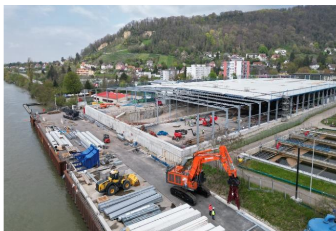
Die Halle der Grundwasserreinigungsanlage auf dem Schiffsanleger wurde bereits demontiert.
