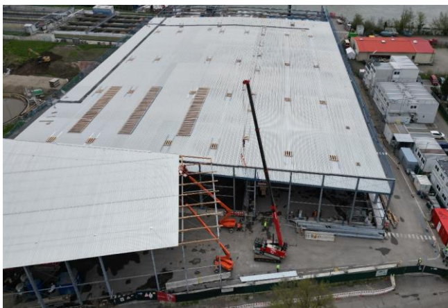
Auch das Dach der Logistikhalle am Heerweg wird derzeit zurückgebaut.
