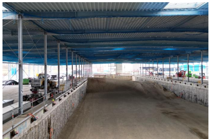
Die unter dem Kopfbalken liegende Bohrpfahlwand wird eingekürzt und an vierzehn vorgegebenen Stellen geöffnet, damit sich die natürlichen Grundwasserströme wiedereinstellen können. Quelle: Pressefoto Roche.
