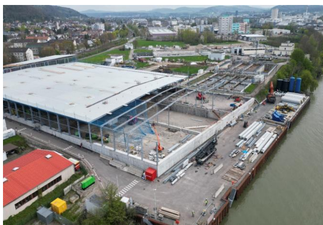
Bis ca. Ende April 2023 wird die Sanierungshalle komplett zurückgebaut sein.
