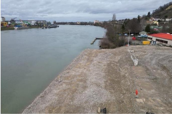
Der temporäre Schiffsanleger ist komplett zurückgebaut. Ein Teil des Erdmaterials wird für die restliche Wiederverfüllung verwendet. Quelle: Pressefoto Roche.
