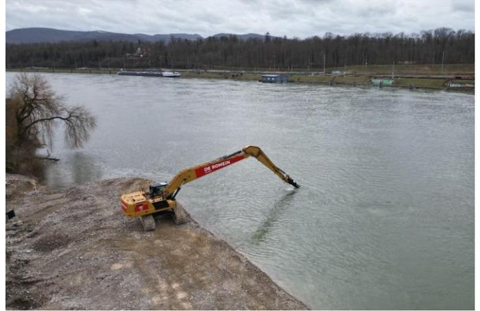
Im Bereich des Schiffsanlegers wird die Vorschüttung erstellt, welche die zukünftige Flachwasserzone schützt. Quelle: Pressefoto Roche.
