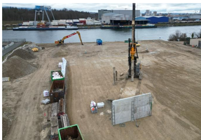
Unter anderem werden zum Schutz der unmittelbaren Nachbarschaft mobile Lärmschutzwände eingesetzt. Quelle: Pressefoto Roche.
