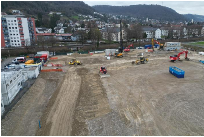
Bis voraussichtlich Mitte April 2024 wird das Gelände profiliert und in seinen ursprünglichen topographischen Zustand zurückversetzt. Quelle: Pressefoto Roche.
