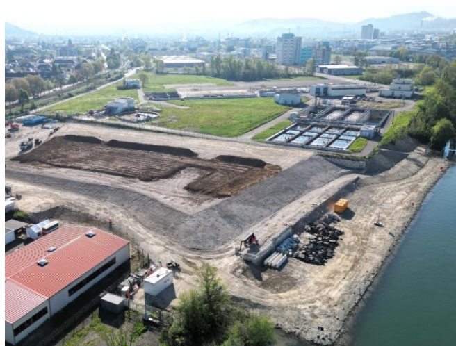
Das Gelände wird in den ursprünglichen topographischen Zustand zurückversetzt.
