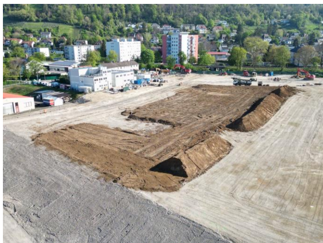
Im Rahmen der Rekultivierung werden ein Unter- sowie ein Oberboden eingebracht.
