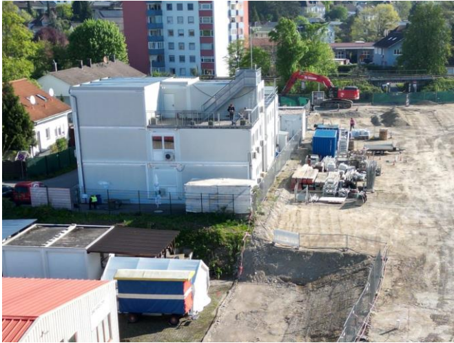
Die ehemaligen Roche-Bürocontainer werden abgebaut und der Gemeinde zur Verfügung gestellt. Quelle: Pressefoto Roche.
