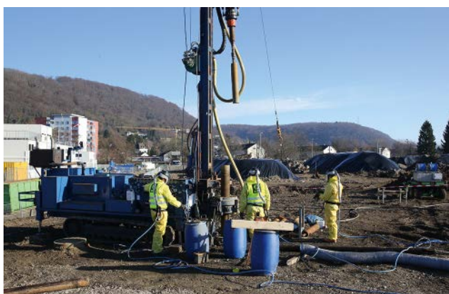
Abbildung 3: Vordeklaration des Aushubs anhand von 142 Rasterbohrungen mit umfangreicher abfallrechtlicher Analytik und Spezialanalytik an ca. 1.800 Abfall- und Bodenproben. Dies ermöglicht eine Just-in-time-Logistik von Aushub und Abtransport.
