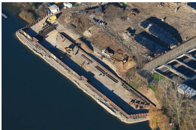
Abbildung 2: Bau des temporären Schiffsanlegers. Luftaufnahme vom 3. Dezember 2015. Quelle: Pressefoto Roche
