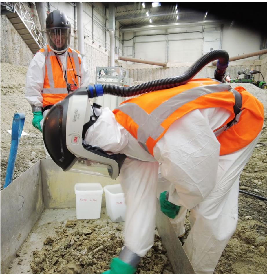
In den Bereichen der Baugrube, in denen die geplante Aushubtiefe erreicht worden ist, wurden Bodenproben zur Schadstoffanalyse entnommen; Quelle: Pressefoto Roche.
