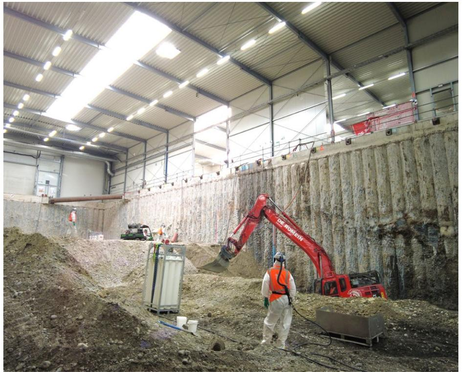
Die Analyse-Ergebnisse der finalen Sohlbeprobung haben bestätigt, dass in den Bereichen, in denen die geplante Aushubtiefe bereits erreicht worden ist, die Schadstoffquellen vollständig entfernt worden sind; Quelle: Pressefoto Roche.
