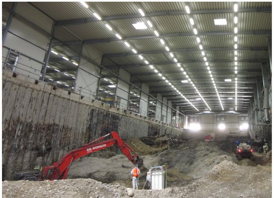
Im vorderen, zum Heerweg gerichteten Teil des Sanierungsgeländes, wurde die geplante Aushubtiefe bereits erreicht; Quelle: Pressefoto Roche.
