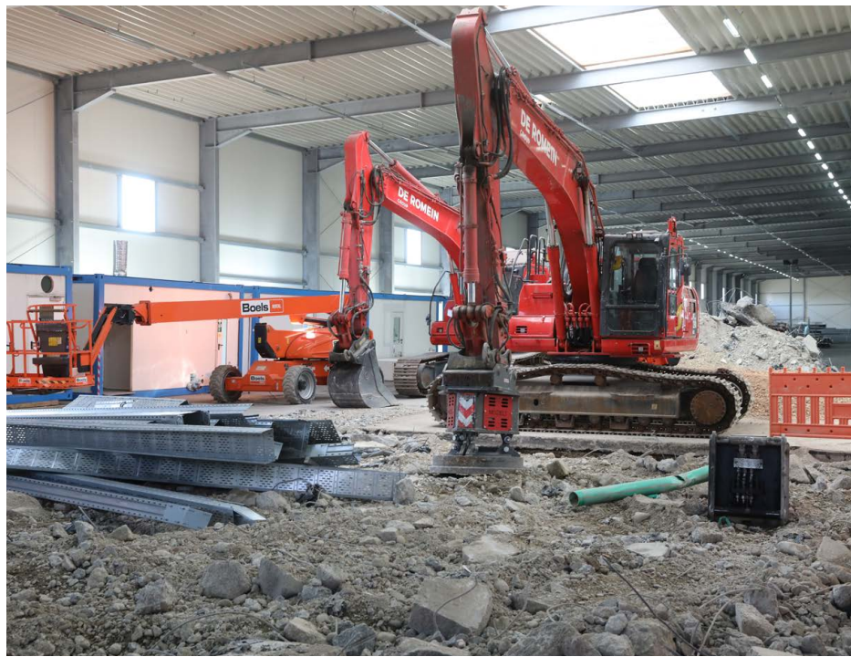
Für die Sanierungslogistik erstellte Asphalt- und Betonflächen wurden entfernt und das Material der Wiederverwertung zugeführt; Quelle: Pressefoto Roche.
