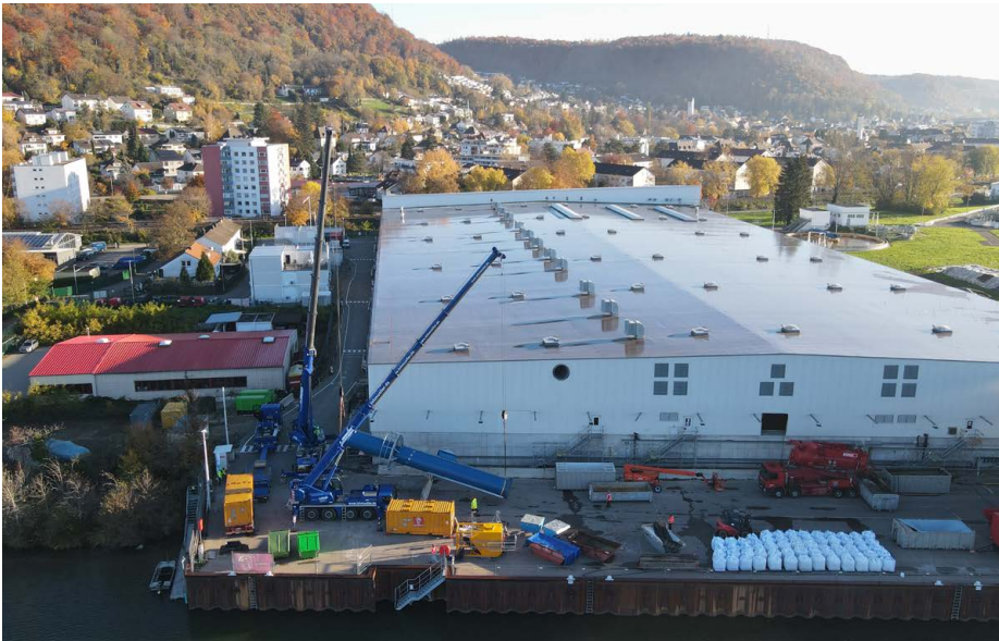
Im Dezember 2022 erfolgten die Demontage und die Verladung des Kamins der Abluftreinigungsanlage; Quelle: Pressefoto Roche.
