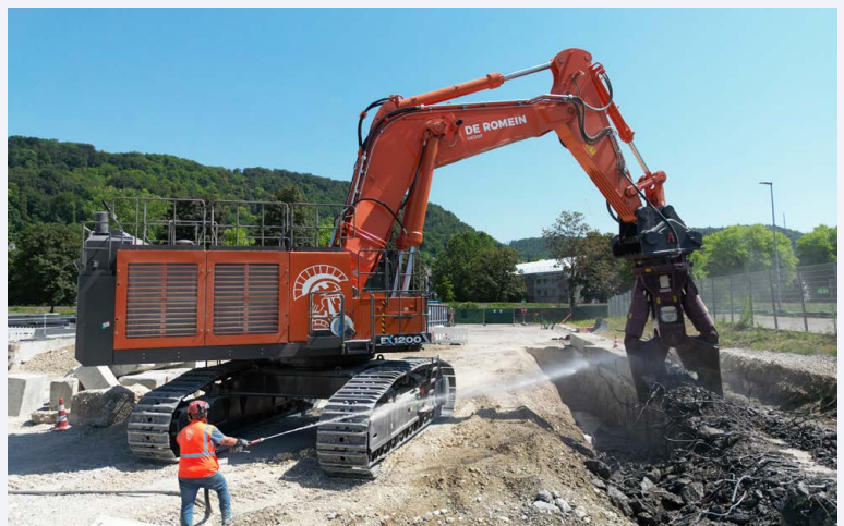
Schneidet Beton nahezu geräuschlos: die Baumaschine des Typs Hitachi EX1200 mit der 14 Tonnen schweren Abbruchscherer; Quelle: Pressefoto Roche.
