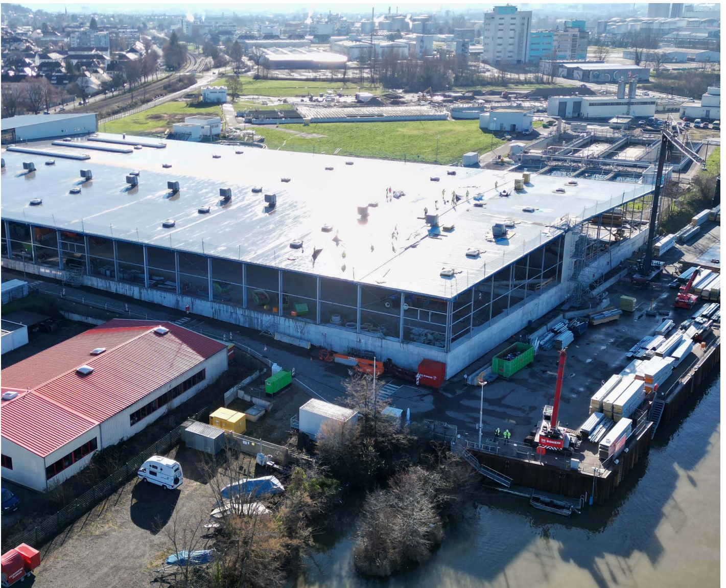
Bis Mitte März 2023 konnten alle Innen- und Außenwände der Einhausung zurückgebaut werden; Quelle: Pressefoto Roche.
