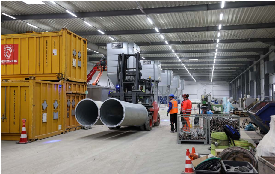
Die Abluftreinigungsanlage und die mit ihr verbundenen Rohrleitungen wurden bis Ende 2022 komplett zurückgebaut; Quelle: Pressefoto Roche.
