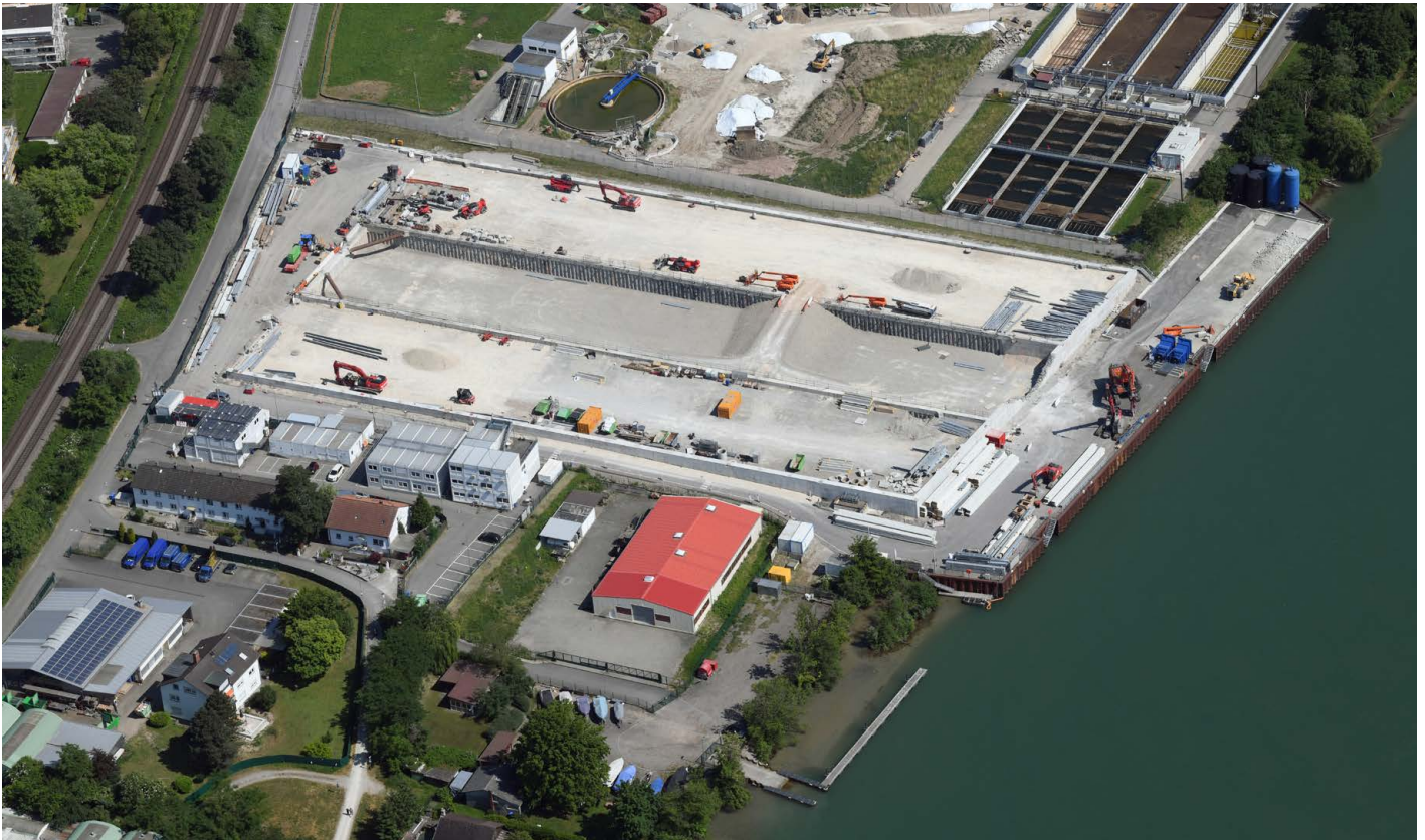
Derzeit erfolgen der Abbruch des Kopfbalkens und das Einkürzen der Bohrpfahlwand; Quelle: Pressefoto Roche.
