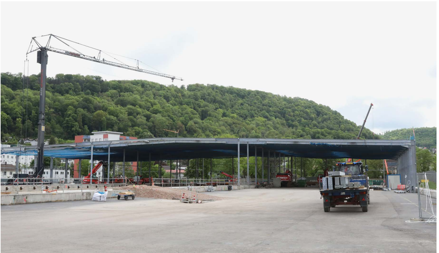
Ein Großteil der Sanierungseinhausung war bis Mitte Mai 2023 bereits zurückgebaut; Quelle: Pressefoto Roche.
