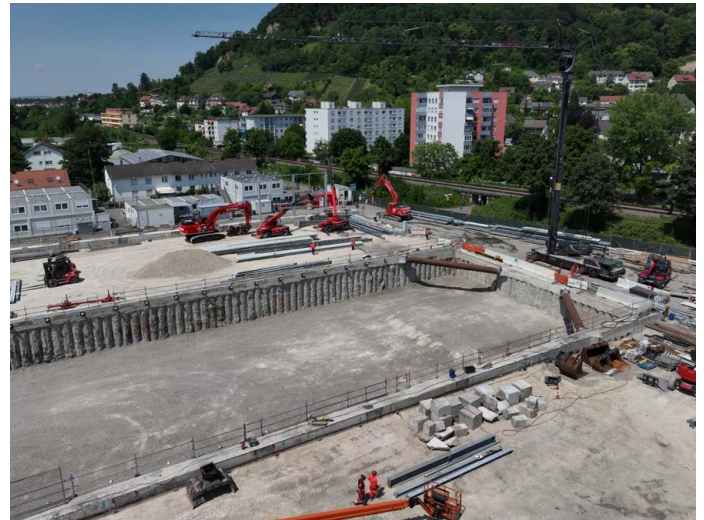
Der vollständige Rückbau der Einhausung endete am 1. Juni 2023; Quelle: Pressefoto Roche.
